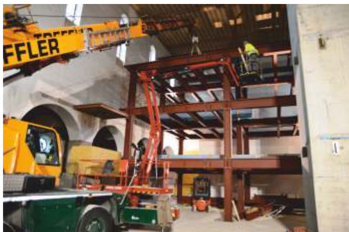
Umbauarbeiten innerhalb des abgetrennten Hauptschiffs 2014. (Bild: ABA, Fotograf: Christoph Meierfrankenfeld)
